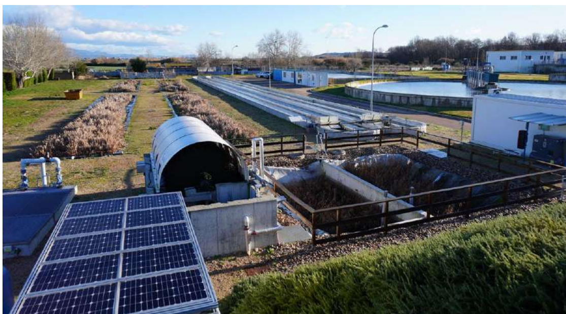
Proyecto de innovación INTEXT, que resuelve el futuro de la depuración en las pequeñas poblaciones.
